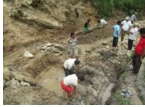
चित्र नं. ४.४ : बाँध तथा मुहान निर्माणको लागि जग खन्ने कार्य
