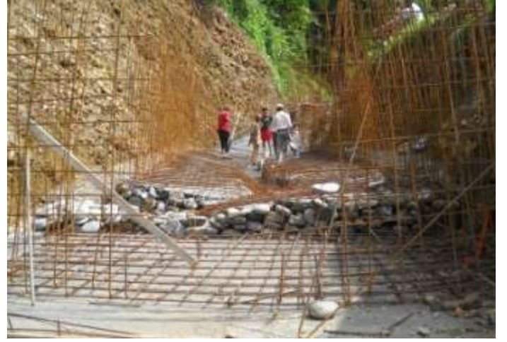
चित्र नं. ४.१० : RCC ढलानको लागि रड बाँध्दै
