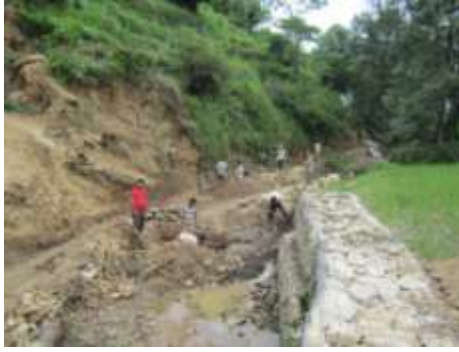
चित्र नं. ४.४ : बाँध तथा मुहान निर्माणको लागि जग खन्ने कार्य
