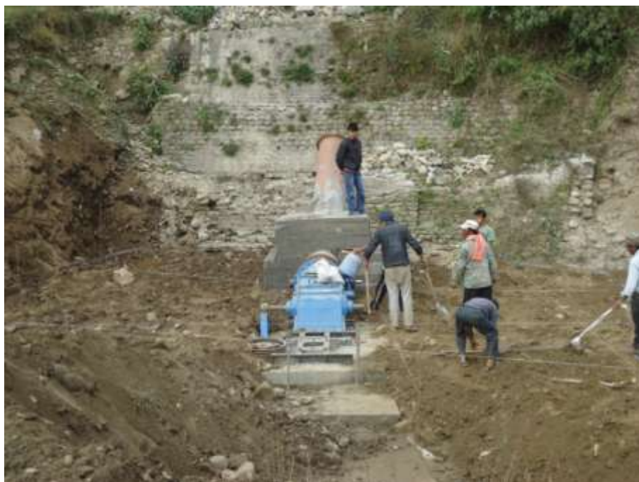
चित्र नं. ४.४१ : पावर हाउसको लाइन (Layout) दिई जग खन्दै
