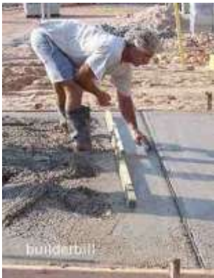
चित्र नं. २.१५ : कंक्रीटको सतह मिलाउने तरिका
