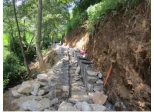
चित्र नं. ४.१६ : कुलोको गारो निर्माण
