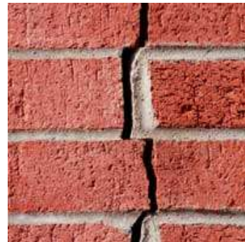
चित्र नं. २.१७ : गलत तरिकाको बाण्डिङ्गका कारण चर्किएको गारो
