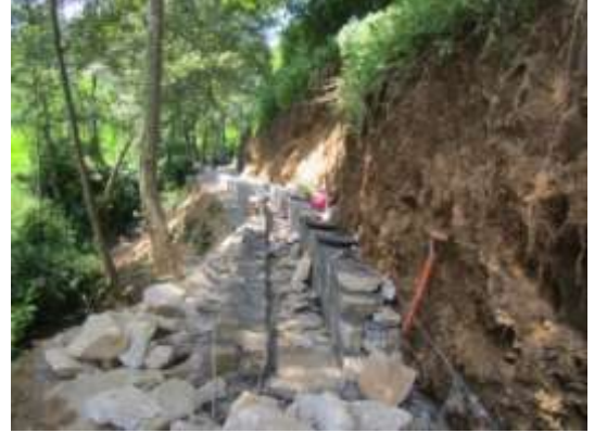
चित्र नं. ४.९ : कूलो र डिसिल्टिङ्ग बेसिनको सतह मिलाएर निर्माण गर्दै
