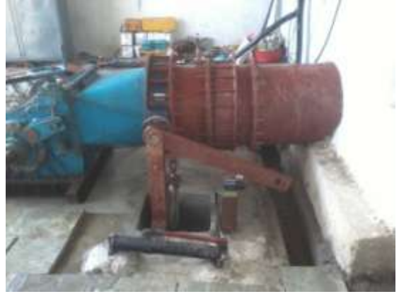
चित्र नं. ४.४६ : पावर हाउसको भित्र कुनामा बनाइएको डक्ट/खोल्सो
